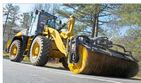
道路清掃・維持作業
