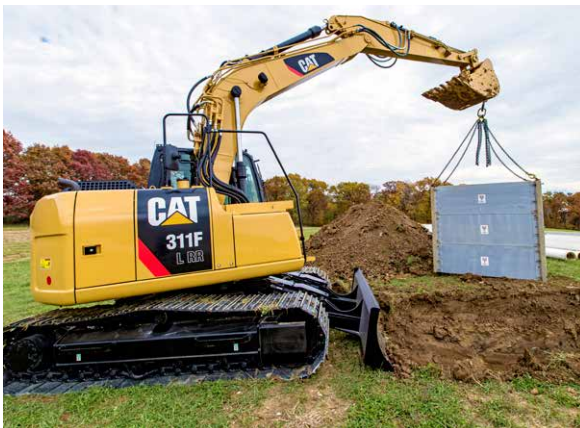
ショベルクレーン仕様による吊荷作業
