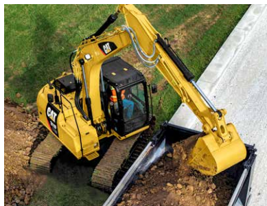
ロングアームによる積込作業
