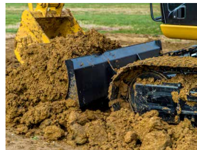
ブレードによる押土作業
