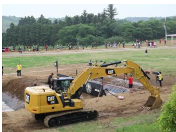
施工した新型油圧ショベル 「Cat 320」
