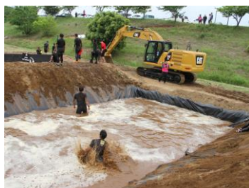
日本キャタピラーが施工した障 害物「ローリングマッド」
