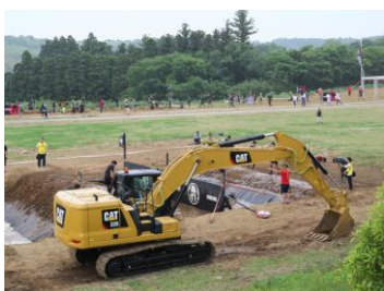
コースを施工したCat 320 (新型油圧ショベル)
