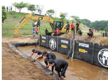
ICT施工した障害物「ダンクウォール」
